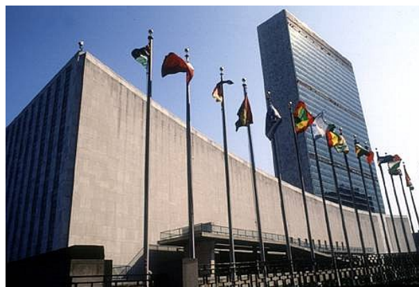
Obr. 18: Budova OSN Zdroj: neac.eu
